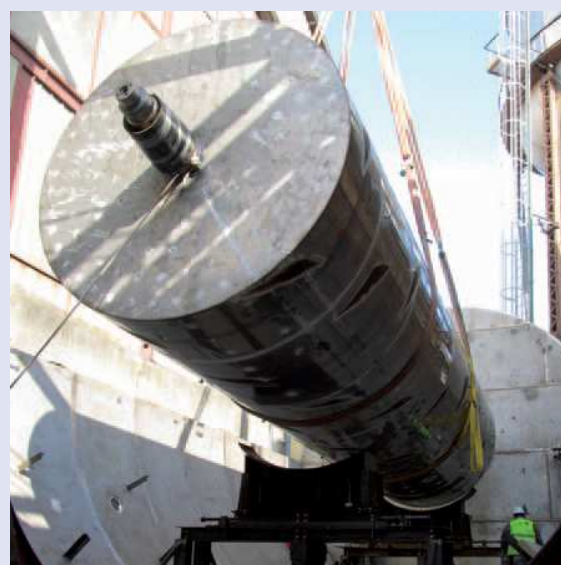
Montage du malaxeur
